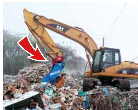
● (CAT.320D) マスチコ (破碎機) 装着
