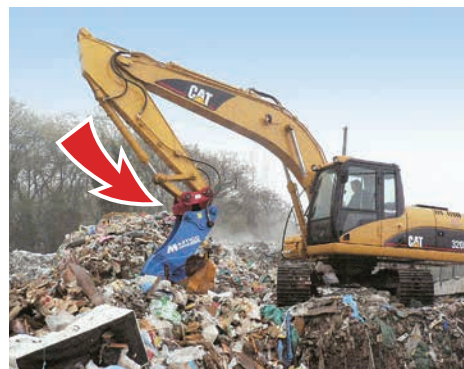
● (CAT.320D) マスティコ(破碎機)装着
